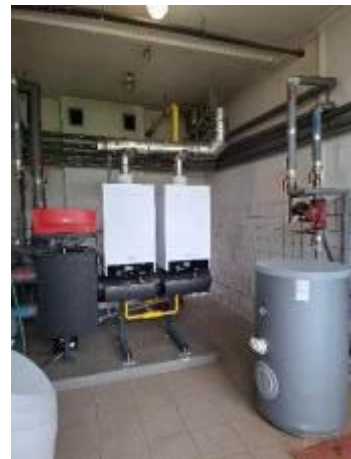
Wymiana pieca gazowego
