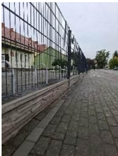
Wymiana i montaż ogrodzenia panelowego , podmurówki, słupków, bram i furtek z przodu budynku
