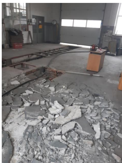
w trakcie remontu
