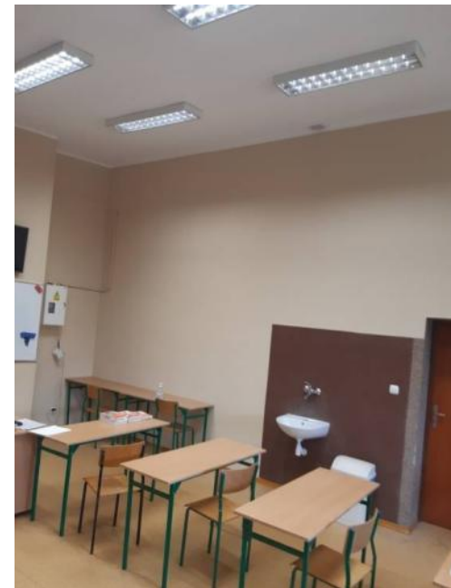
Naprawa tynków i odmalowanie klasy szkolnej (TPS) w budynku „K” (warsztaty szkolne) na terenie CKZiU. kwota 7.380,00 zł.
