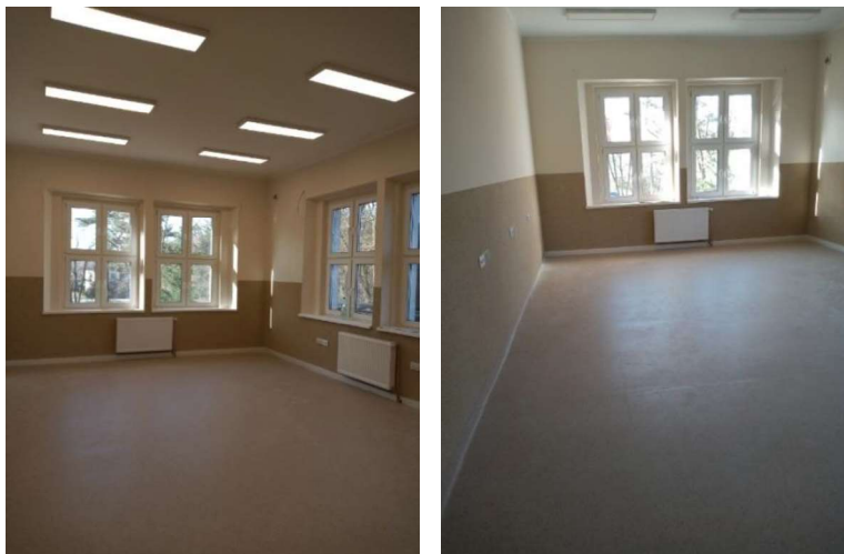
Remontowane sale w CKZiU w Wołowie
