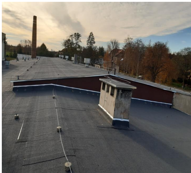
„Modernizacja budynku warsztatów Centrum Kształcenia Zawodowego i Ustawicznego w Wołowie – wymiana pokrycia dachu”. 88.024,94 zł
