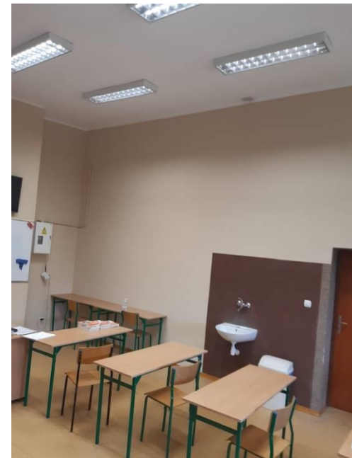
Naprawa tynków i odmalowanie klasy szkolnej (TPS) w budynku „K” (warsztaty szkolne) na terenie CKZiU. kwota 7.380,00 zł.
