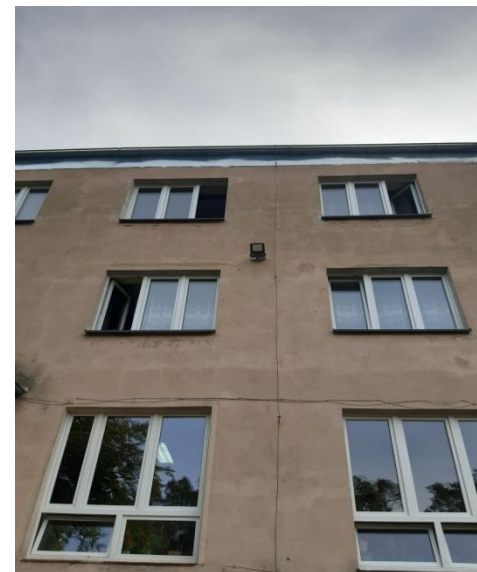
Wymiany okien w budynku „F” (bursie szkolnej) za kwotę 48.186,82 zł.
