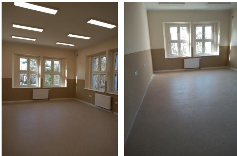
Remontowane sale w CKZiU w Wołowie
